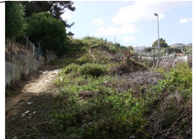
Final do túnel
